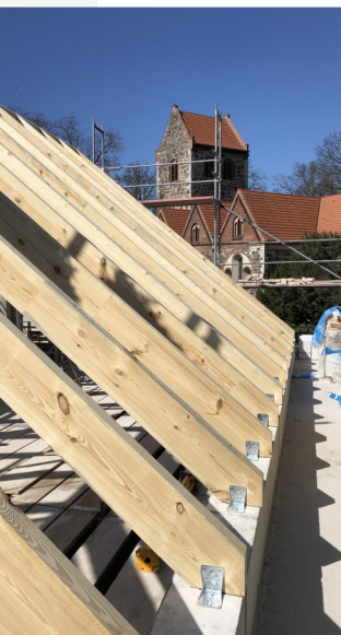
Das Richtfest des neuen Gemeindezentrums fand im April 2020 statt.
